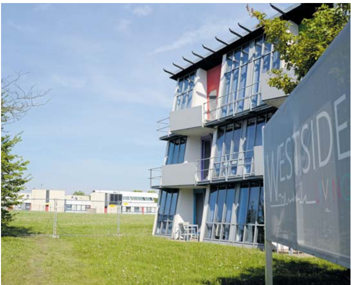
Zwischen den Apartmenthäusern Auf dem Dataport-Gelände werden schon Vorbereitungen für den Bau des Druckzentrums und des Trainingskomplexes geschaffen. FOTO: KERSTIN V. SCHMIDT-PHISELDECK
