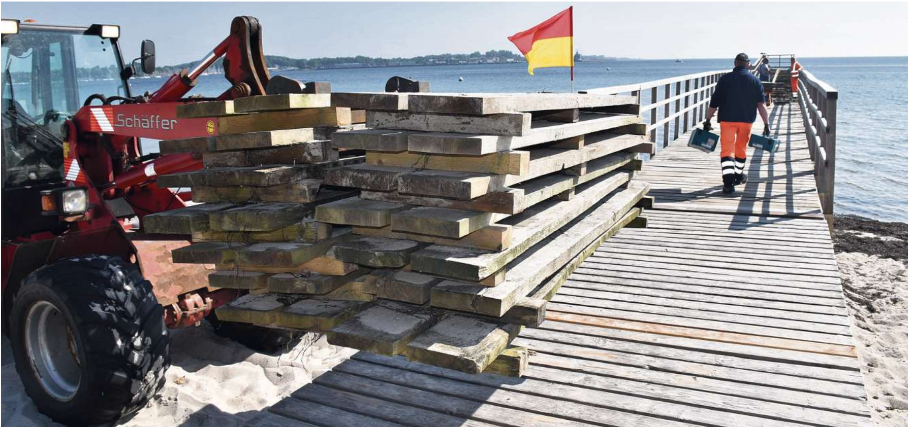
Letzte Arbeiten: Handwerker des Bauhofs bringen die Eichenbohlen des Stegs „Kiek in de See“ auf. In diesen Tagen soll er wieder frei zugänglich sein.
