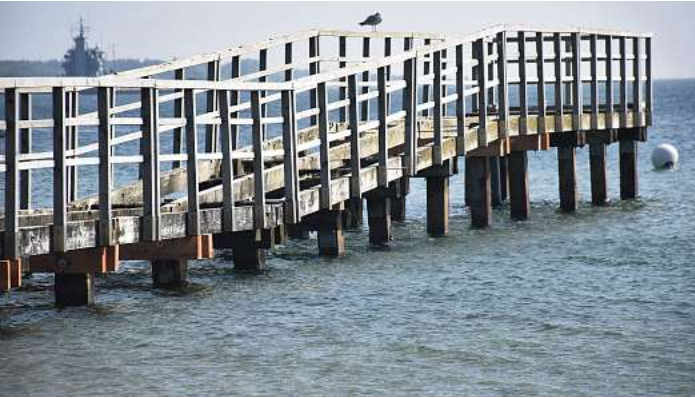
Die erneuerten Querträger am Unterbau sind gut zu erkennen, denn das frische Holz ist noch hell. Die Zimmerer verwendeten Lärche.
